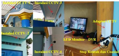
**Gambar 2 Instalasi Sistem CCTV**
