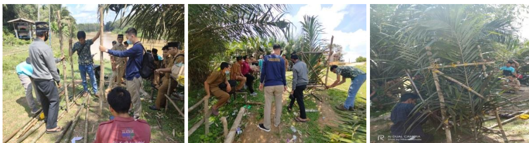
Gambar 4. Proses Perakitan Rumah Ikan (Rumpon)
