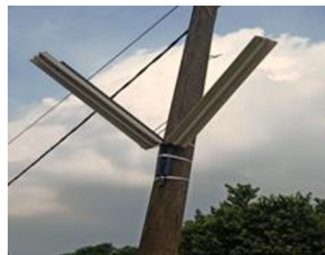
Gambar 9. Hasil pemasangan PJU
