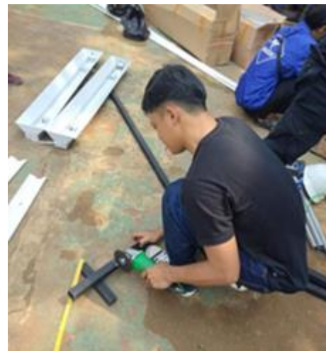
Gambar 5. Pembuatan konstruksi PJU
