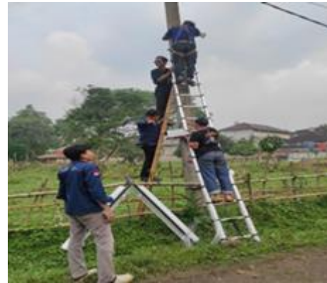
Gambar 8. Pemasangan konstruksi PJU lainnya
