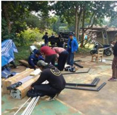
Gambar 6. Perakitan konstruksi PJU
