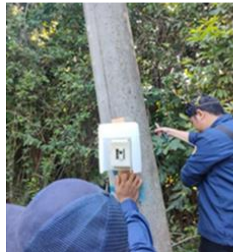
Gambar 4. Pemasangan MCB
