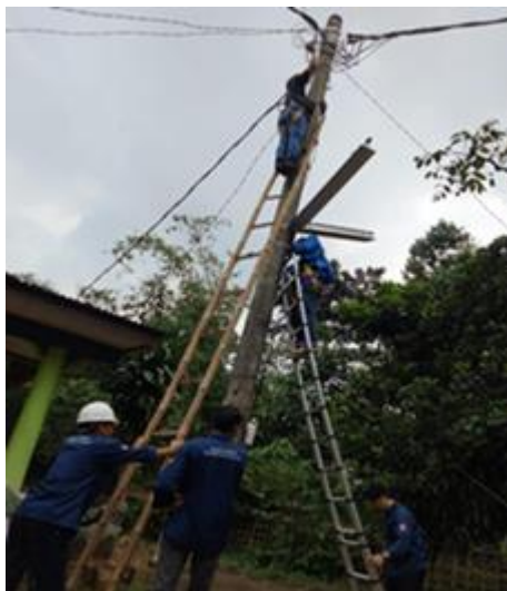
Gambar 7. Pemasangan konstruksi PJU
