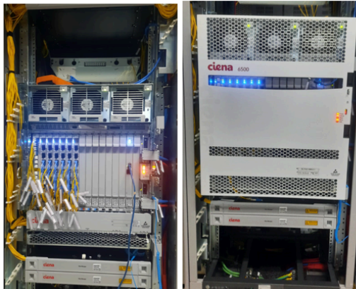
Gambar 9. Contoh hasil pemasangan perangkat upgrade Ciena 6500 pada SEA-US
