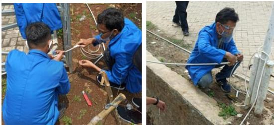
Gambar 5 Melakukan instalasi kabel lampu taman
