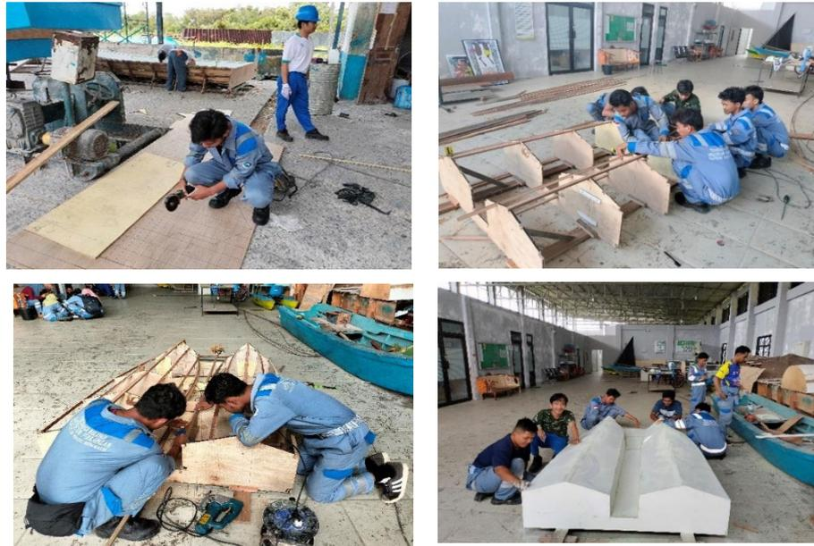
**Gambar 4 Proses pembuatan cetakan sepeda Air**
