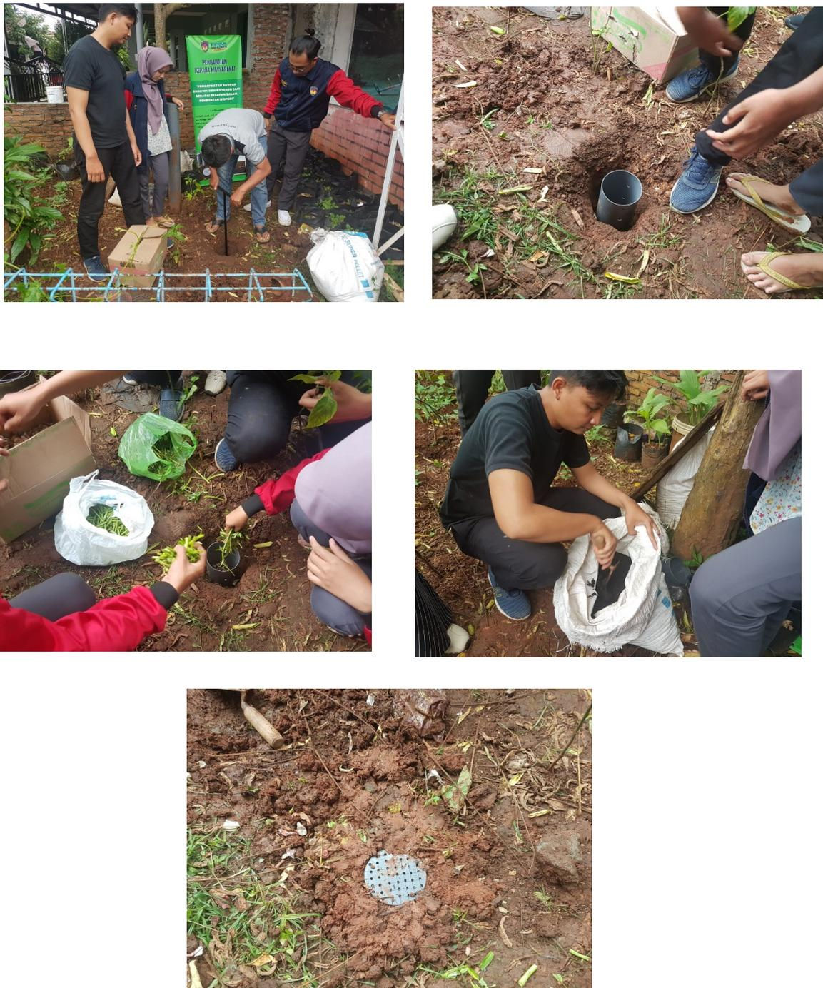
**Gambar 3: Proses Pembuatan Lubang Resapan Biopori**
