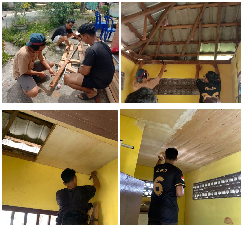
Gambar 2. Penggantian Plafon, Rangka Atap dan Atap
