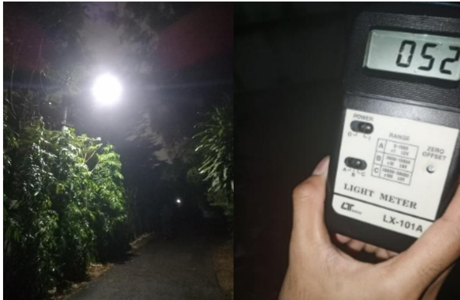
Gambar 3 Pengujian Kuat Cahaya Lampu Panel Surya
