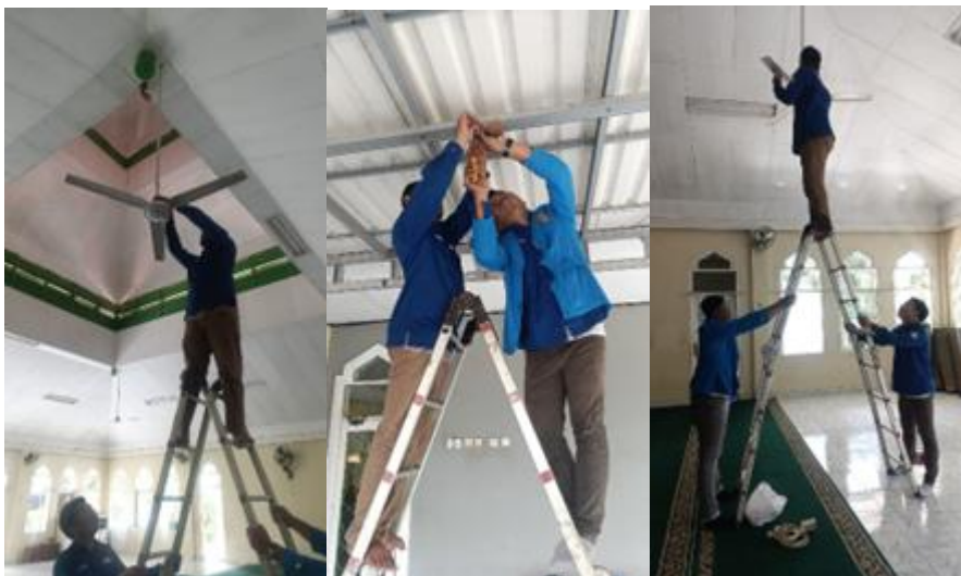
Gambar 4 Pemasangan 3 unit kipas angin
