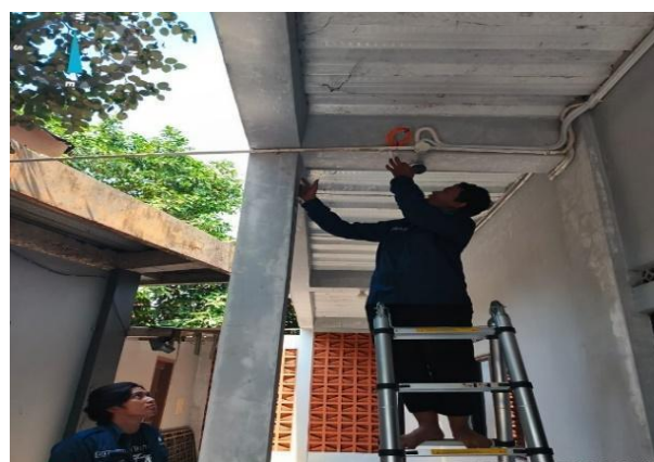
Gambar 2 observasi dan pengecekan CCTV
