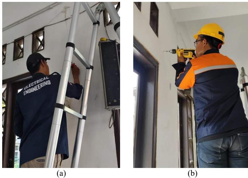
Gambar 4 Pemasangan stop kontak (a) Lantai 1, dan (b) Lantai 2
