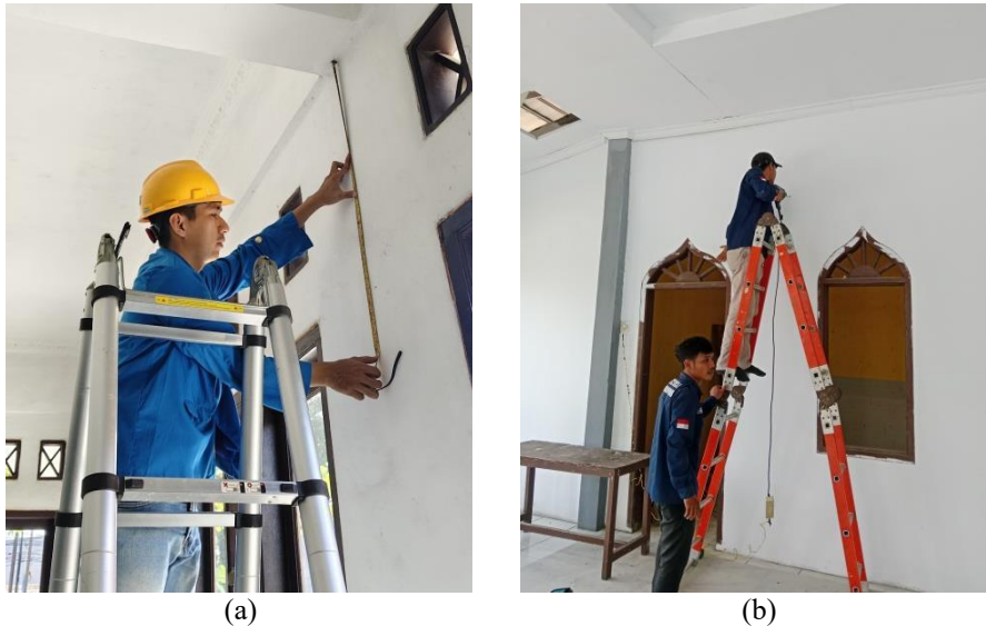
Gambar 3 (a) Pengukuran ketinggian kipas, dan (b) Pemasangan braket kipas
