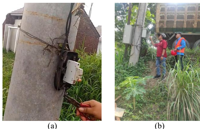
Gambar 3 Pemasangan (a) MCB tidak standar dan (b) perbaikan instalasi
