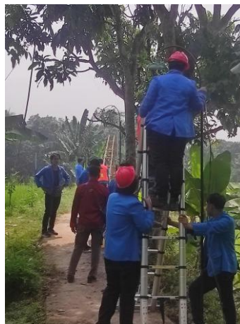
Gambar 5 Pemasangan tiang dan perbaikan instalasi kabel listrik PJU
