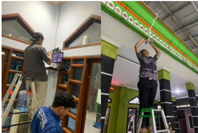
Gambar 3 Pemasangan CCTV dan perangkat recorder
