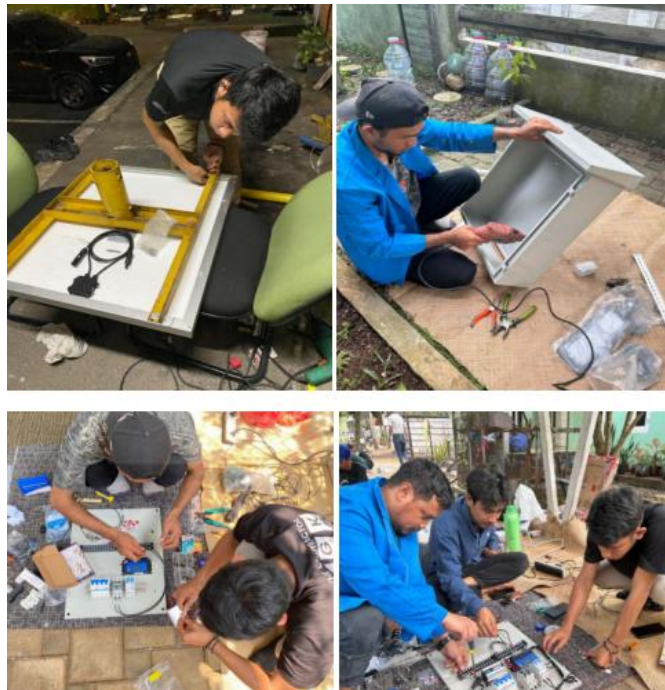
Gambar 2 Proses perakitan komponen
