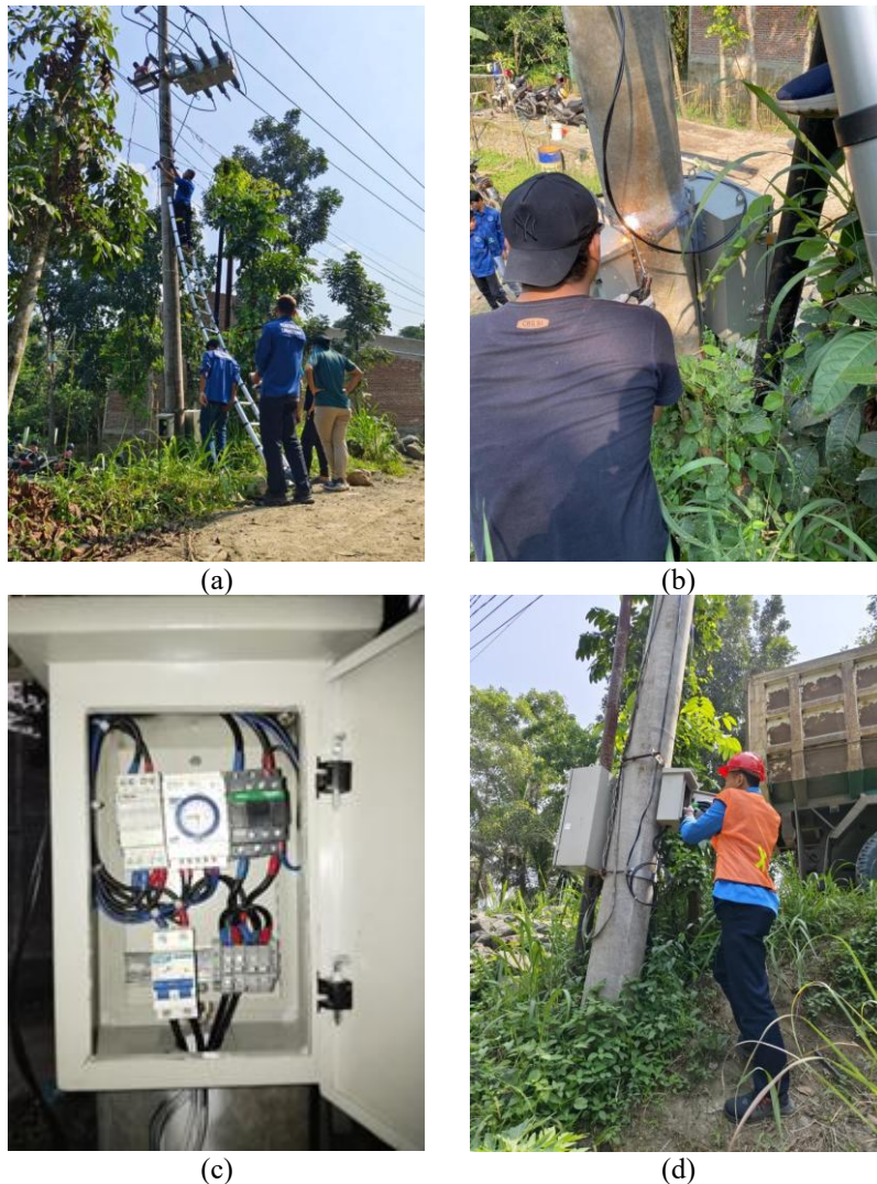
Gambar 2 (a) Koneksi Power dari tiang PLN, (b) Pengelasan bracket panel kontrol, (c) Wiring mounting panel, (d) Setting panel kontrol
