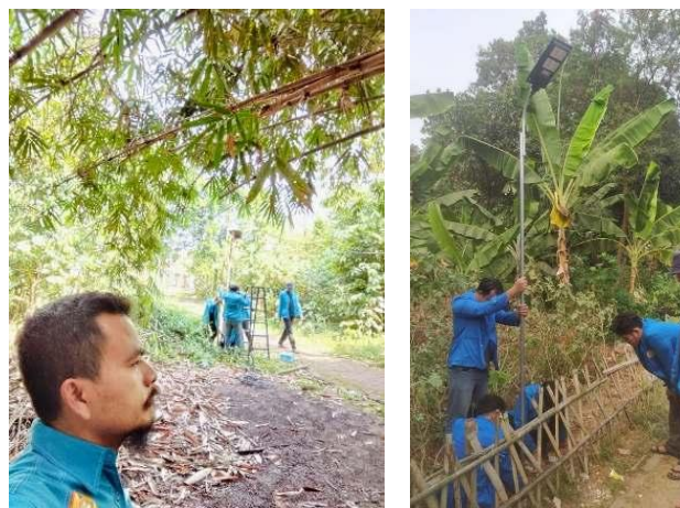
(a) (b) Gambar 3 Pemasangan ting lampu
