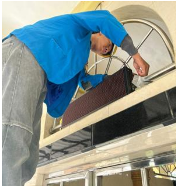
Gambar 1 proses pemasangan running text
