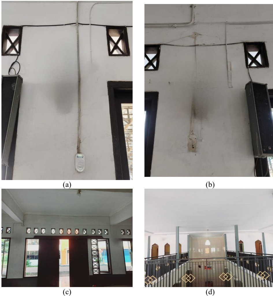
Gambar 2 Titik pemasangan (a) Lantai 1 bagian tengah sebelah kiri, (b) Lantai 1 bagian tengah sebelah kanan, (c) Lantai 1 bagian belakang, dan (d) Lantai 2 bagian depan
