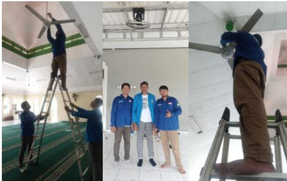
Gambar 3 Instalasi kipas angin
