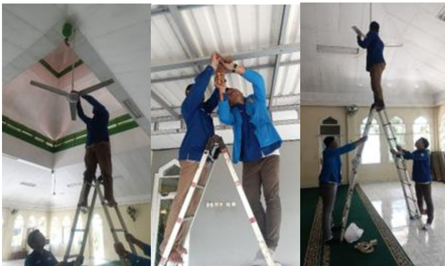
Gambar 4 Pemasangan 3 unit kipas angin
