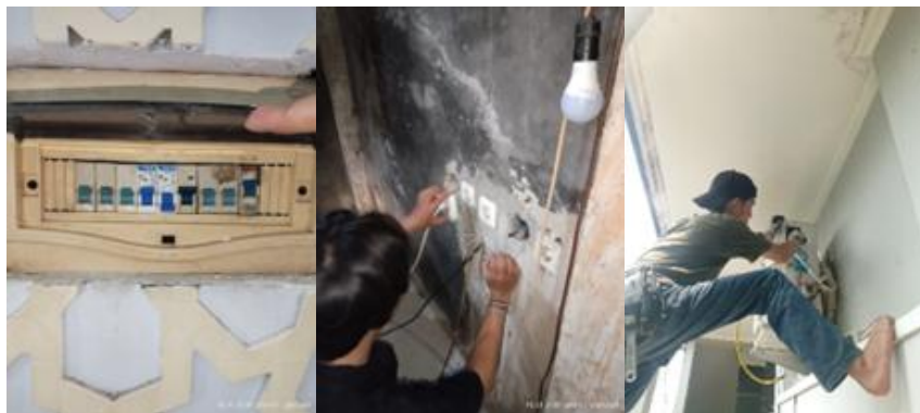
Gambar 3 Pemasangan lampu, penerangan dan perawatan AC
