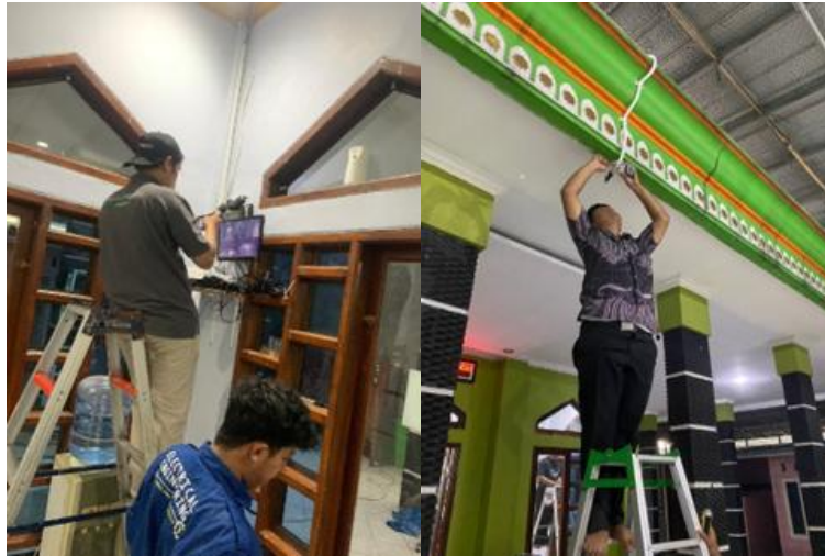
Gambar 3 Pemasangan CCTV dan perangkat recorder
