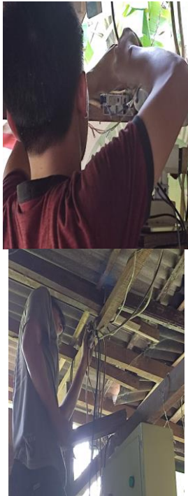
Gambar 4. Pemasangan kabel dan komponen pada panel.
