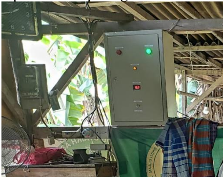
Gambar 5 Dokumentasi Hasil Instalasi ATS
