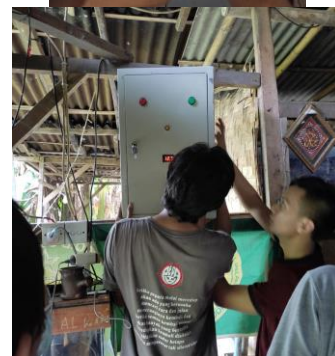
Gambar 3. Pemasangan komponen ATS dan proses instalasi
