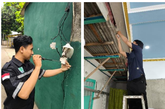
Gambar 3. Proses Perbaikan Pemasangan MCB dan Perbaikan Alur Instalasi Listrik
