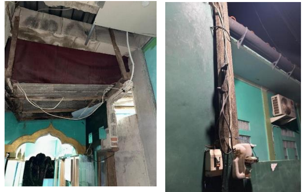
Gambar 2. Kondisi Pemasangan MCB dan Alur Instalasi Listrik Saat Survei
