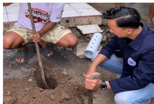
Gambar 5. Membuat Lubang Resapan
