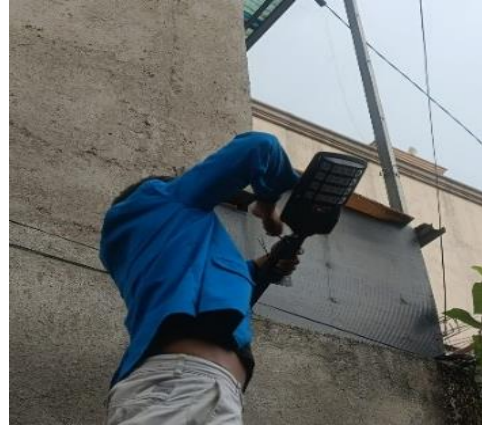
Gambar 4. Pemasangan lampu PLTS yang telah ditentukan lokasinya
