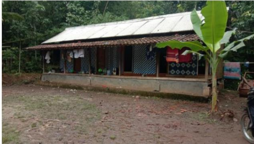
Gambar 1. Kondisi bangunan sebelum melakukan pembaruan instalasi listrik
