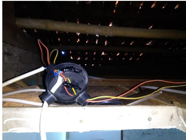
Gambar 3. Kondisi Instalasi setelah diperbaiki
