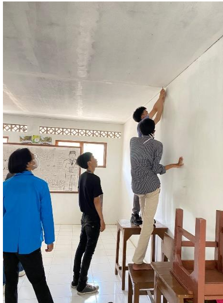
Gambar 5. Pemasangan Stop Kontak
