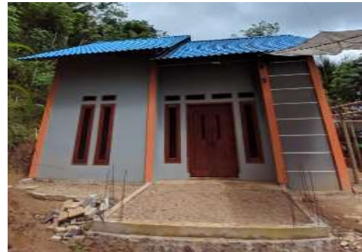
Kondisi Rumah Setelah Mendapatkan Bantuan BSPS
