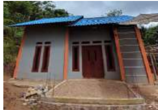
Kondisi Rumah Setelah Mendapatkan Bantuan BSPS
