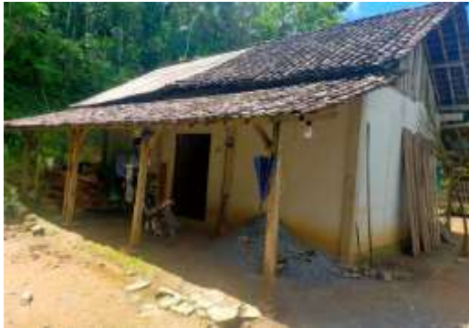
Kondisi Rumah Sebelum Mendapatkan Bantuan BSPS
