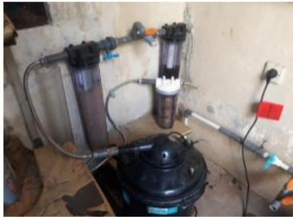
Gambar 4. Peralatan dan komponen Proses demineralisasi menggunakan resin penukar ion.
