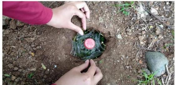
Gambar 5. Memanfaatkan botol plastic bekas untuk dijadikan tutup lubang biopori
