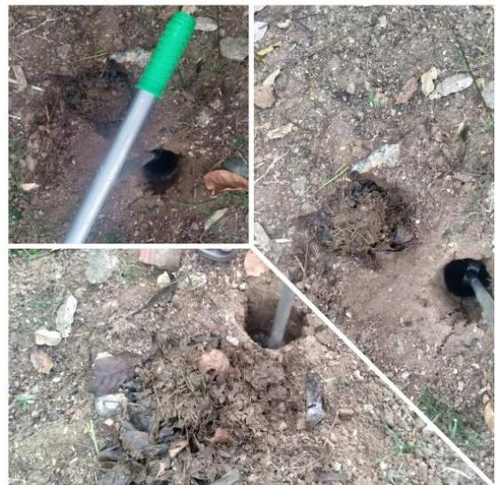
Gambar 6. Sampah organik yang telah berada didalam lubang biopori
