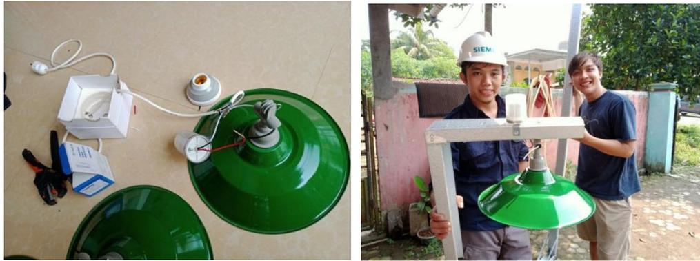
Gambar 5 Mempersiapkan lampu dan sensor photocell
