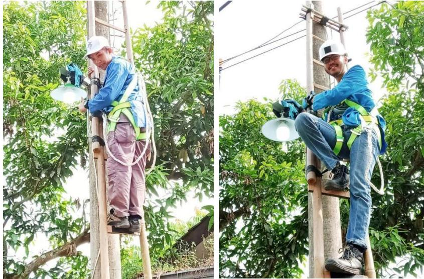
Gambar 3 Hasil uji coba lampu dengan sensor photocell
