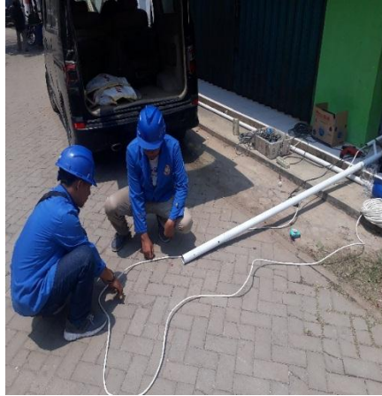
Gambar 6 Proses Pemasangan Kabel Tiang Lampu Penerangan.
