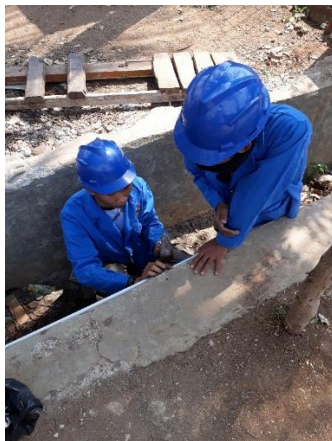
Gambar 12 Proses Pemasangan Pipa Konduit Pada Kabel.
