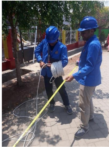
Gambar 8 Proses instalasi kabel antar tiang.
