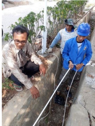
Gambar 11 Proses Pemasangan Pipa Konduit Pada Kabel.
