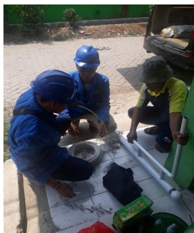
Gambar 5 Proses Pemasangan Kabel Tiang Lampu Penerangan.
