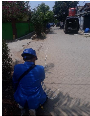
Gambar 9 Proses instalasi kabel antar tiang.
