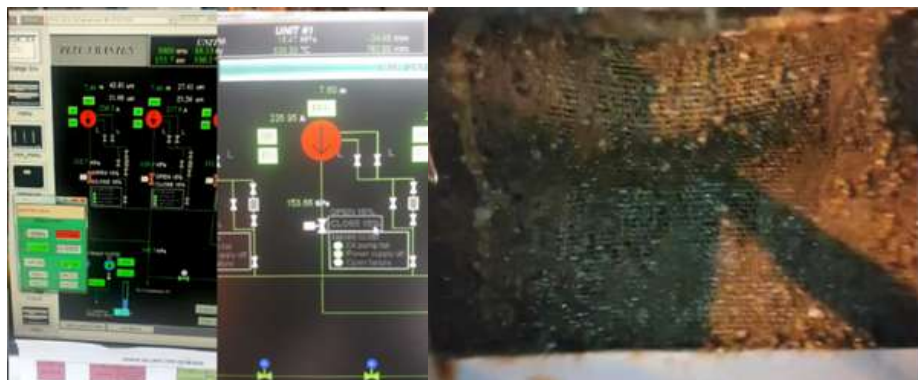
Gambar 4. Kegagalan operasi saat menutup butterfly valve HPU CWP.
