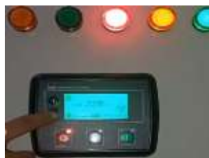
Gambar 7. Pengujian beban dengan monitoring modul deep sea 4250.
