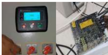
Gambar 6. Pengujian under voltage dan overvoltage pada deep sea 4520.
