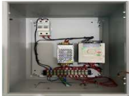
Gambar 2. Hasil rancangan alat pada bagian panel utama.
