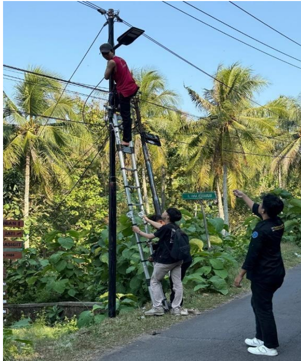
Gambar 2. Pemasangan Penerangan Jalan Umum Berbasis Panel Surya.
