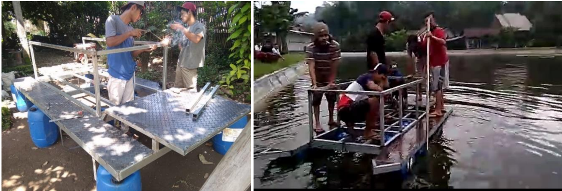
Gambar 2. Pembangunan perancah sampah dan perahu sedimen di waduk
