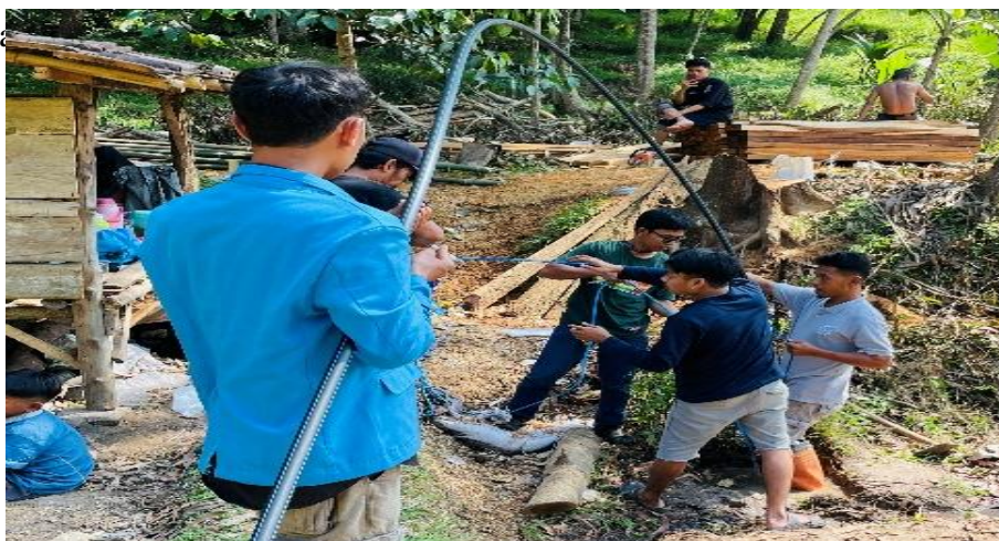
Gambar 4. Instalasi pipa HDPE pada sumur bor
