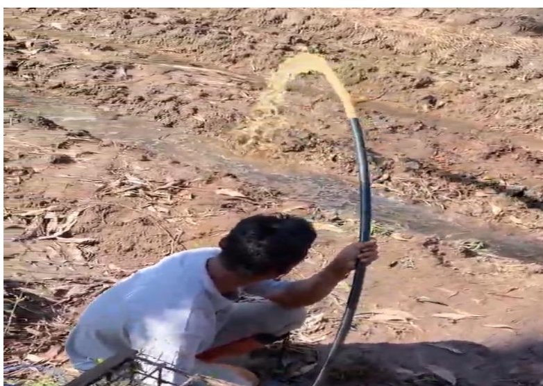
Gambar 5. Ujicoba pipa HDPE setelah di Instalasi
