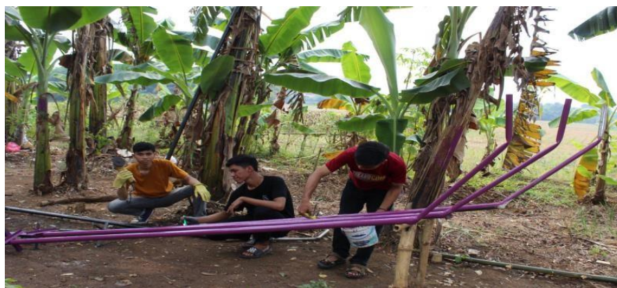
Gambar 6. Proses pengecatan Tiang Lampu
