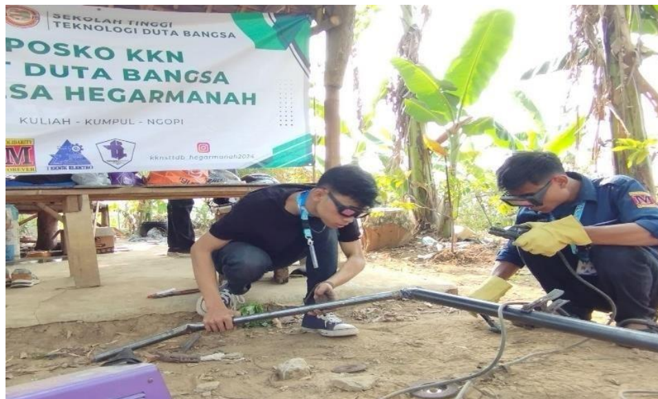
Gambar 5. Proses Pengelasan dan Perakitan Tiang Lampu
