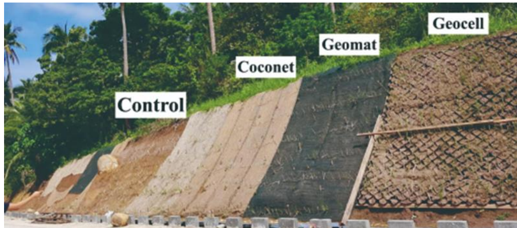
Gambar 1. Rekayasa Proteksi Lereng - Pekerjaan Proteksi Lereng, Geosintetik
