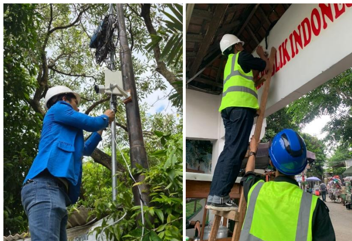
Gambar 4. Proses Pemasangan Sistem CCTV
