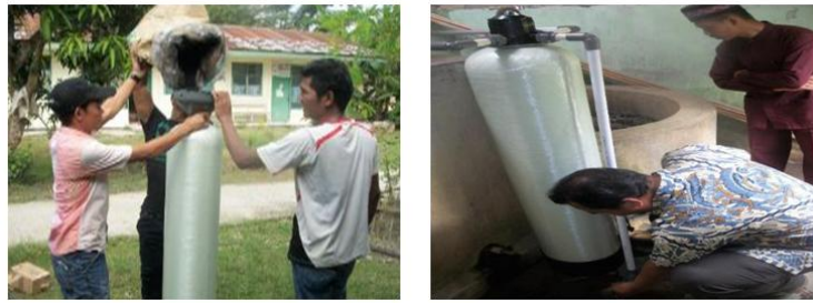
Gambar 1. Kegiatan pelatihan; penjelasan dan penyusunan media filter, dan instalasi tabung filter
