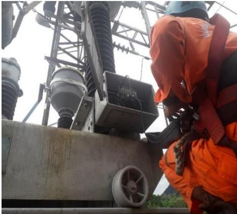
**Gambar 7.** Proses Pengujian Nilai Tahanan Isolasi pada PMT
