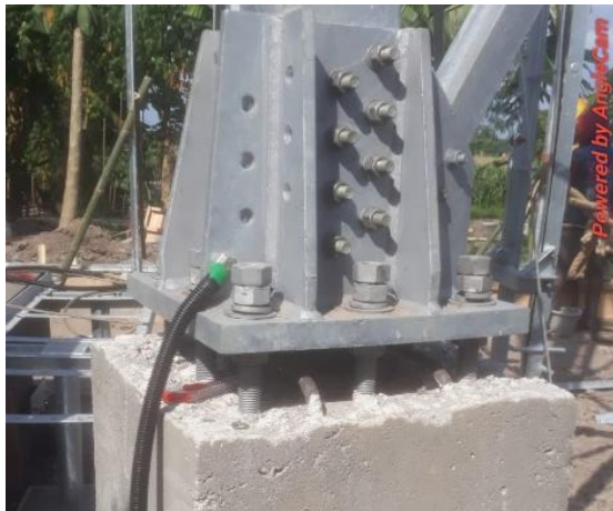
Gambar 4. Penyambungan Kabel BC Spiral Ke Kaki Tower
