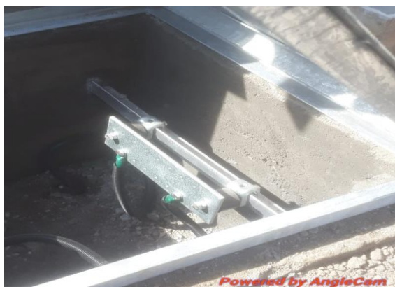
Gambar 5. Penyambungan Kabel BC Spiral Ke Bak Kontrol
