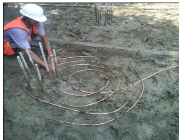
Gambar 3. Pemasangan Kabel BC Spiral
