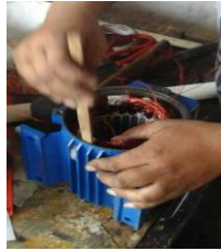
Gambar 2. Proses memasukan kumparan ke dalam alur stator.
