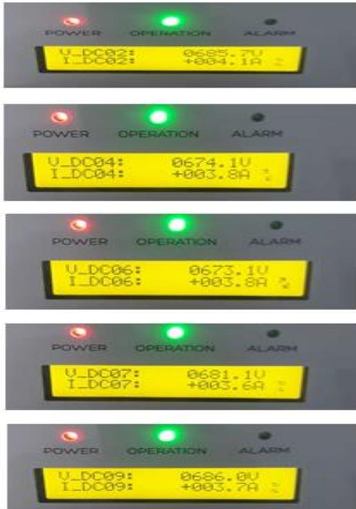
Gambar 7. Monitoring tegangan dan arus PLTS tahap 2
