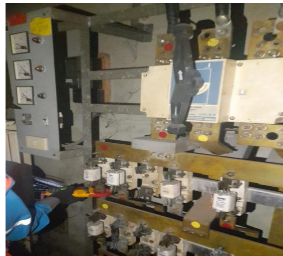
Gambar 7. Pengukuran Arus
