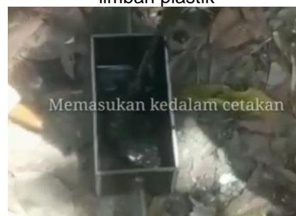
Gambar 4. Memasukkan adonan paving blok ke dalam cetakan
