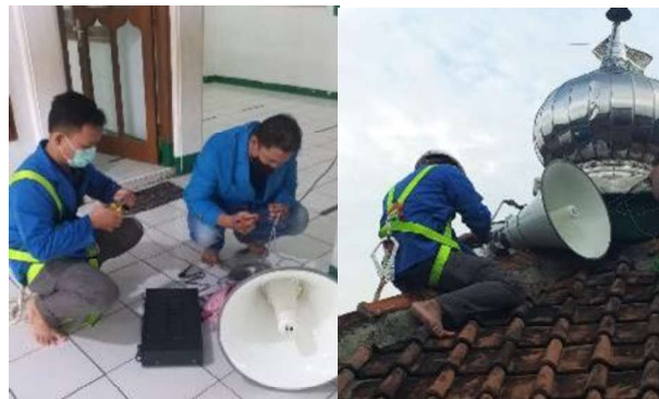
Gambar 7. Perakitan, Persiapan dan Pelaksanaan Instalasi Sistem Tata Suara
