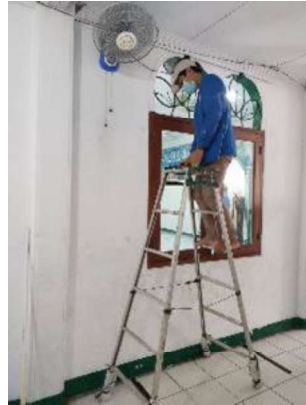
Gambar 6. Proses Standarisasi Instalasi Listrik Masjid
