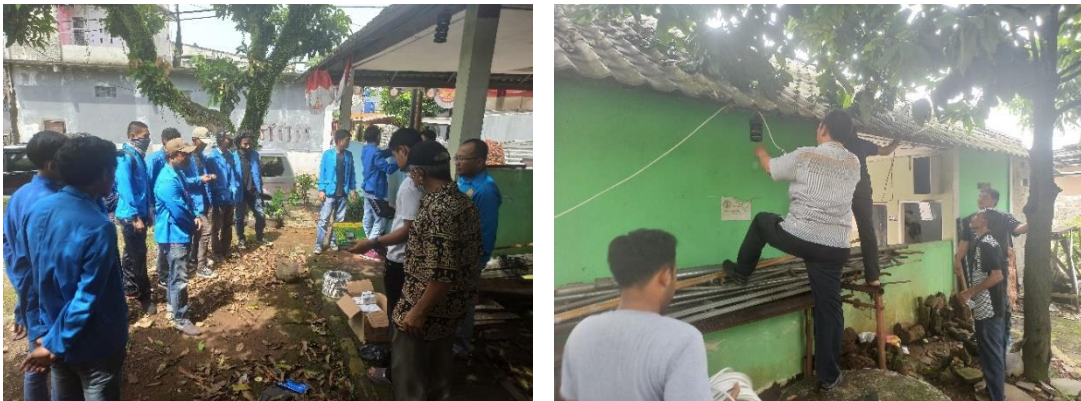
Gambar 5. Perencanaan dan Pemasangan Instalasi Penerangan Lampu Jalan
