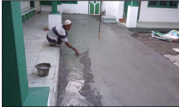
Gambar 4. Proses penyemenan halaman madrasah
