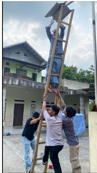
Gambar 5 proses pemeliharaan dan pengecekan titik penerangan mushola
