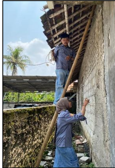
Gambar 3 proses pemeriksaan dan penataan ulang jalur kabel instalasi listrik
