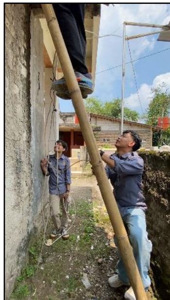
Gambar 4 proses perbaikan dan pengamanan sambungan instalasi listrik
