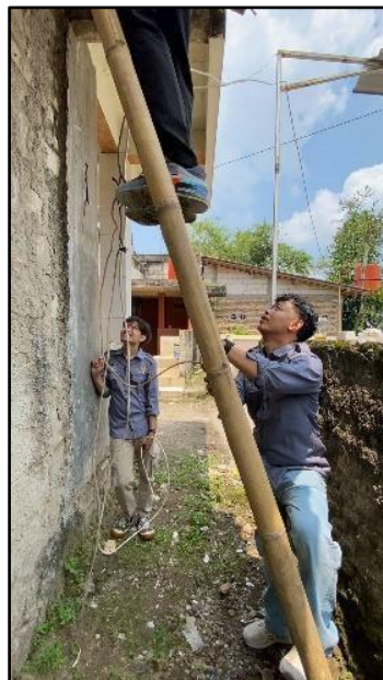
Gambar 4 proses perbaikan dan pengamanan sambungan instalasi listrik
