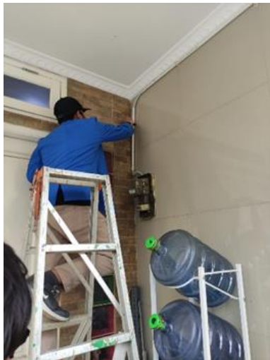
Gambar 3. 1 Proses Pemasangan CCTV di Rumah Ketua RW
