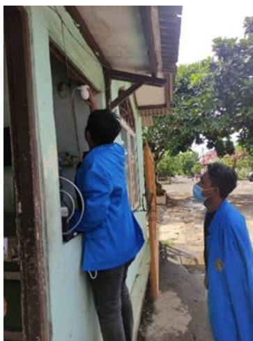
Gambar 3. 3 Proses Pemasangan CCTV di Pos Pintu Masuk
